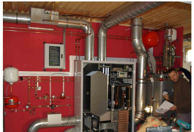
Installation d'une machine compacte (Chauffage-Ventilation-ECS) Pass-I*Lab
